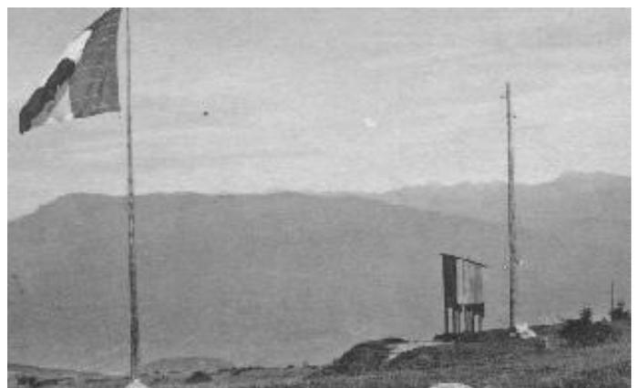
Fig. 28 - Le phare des Treize-Arbres établi en 1913 était visible de Genève et même du Jura ; ce phare comportait une caisse en bois fixée sur deux supports métalliques (seul le support nord reste depuis l'été 2003) ; une dizaine de lampes de 120 volts était alimentée par le courant destiné à la traction des automotrices.
