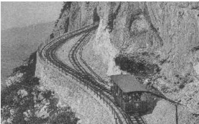
Fig. 33 - Évitement en aval du tunnel (avant 1906) ; au moins deux chutes de rochers générant des dégâts sur la voie ont eu lieu à cet endroit pendant l'exploitation : vers le 1<sup>er</sup> août 1902 et le 19 janvier 1927.
