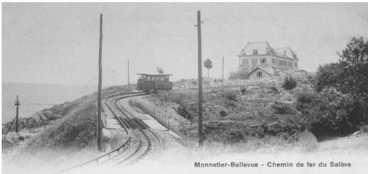
Illust. 14 – Courbe et contre-courbe en aval de la gare principale de Monnetier-Mairie ; à gauche un des poteaux de la ligne électrique d'alimentation du chemin de fer, et le pont n° 19 au-dessus de la route du Salève ; au premier plan deux poteaux de la ligne téléphonique de la Compagnie (photo prise entre 1892 et 1905).
