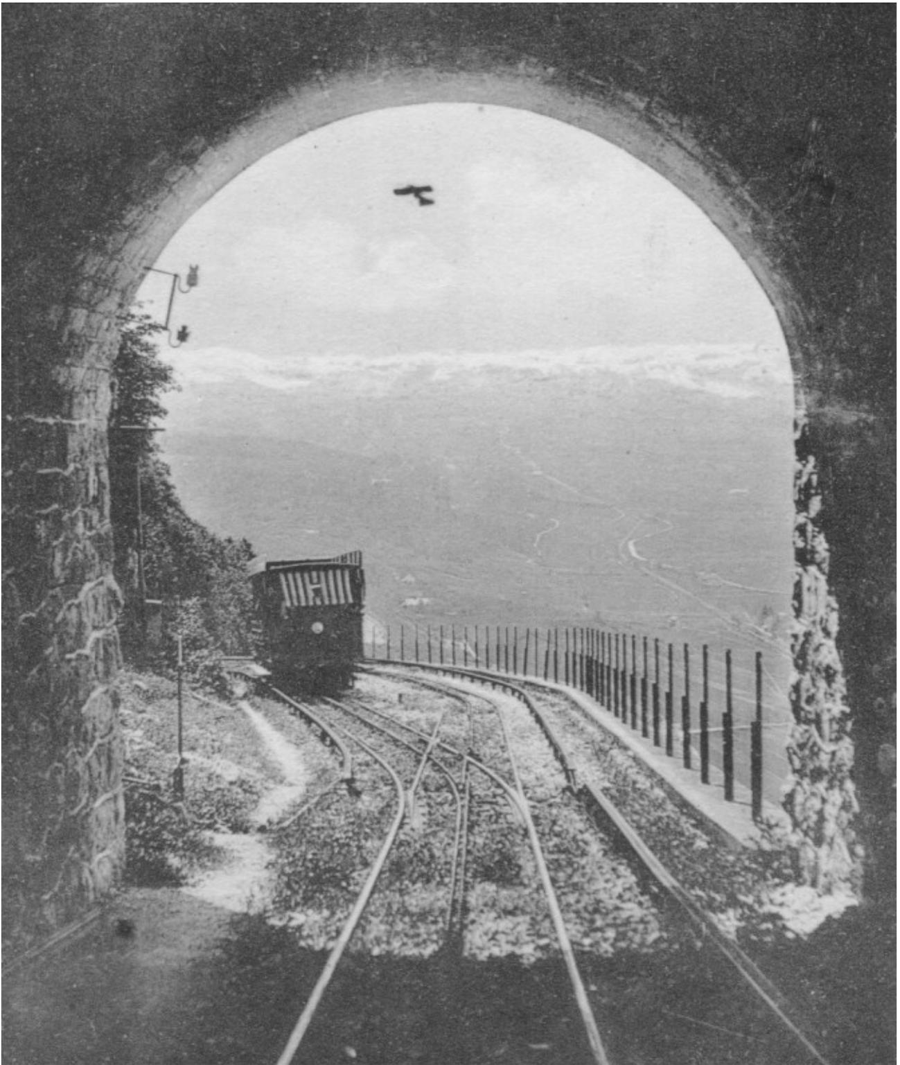
Illust. 37 – Portail aval du tunnel de 119 m de long, large de 3,9 m, de pente 13,5° et orienté à 68° ; au fond, le Vuache enneigé et le Jura ; à gauche les isolateurs des fils du téléphone.
