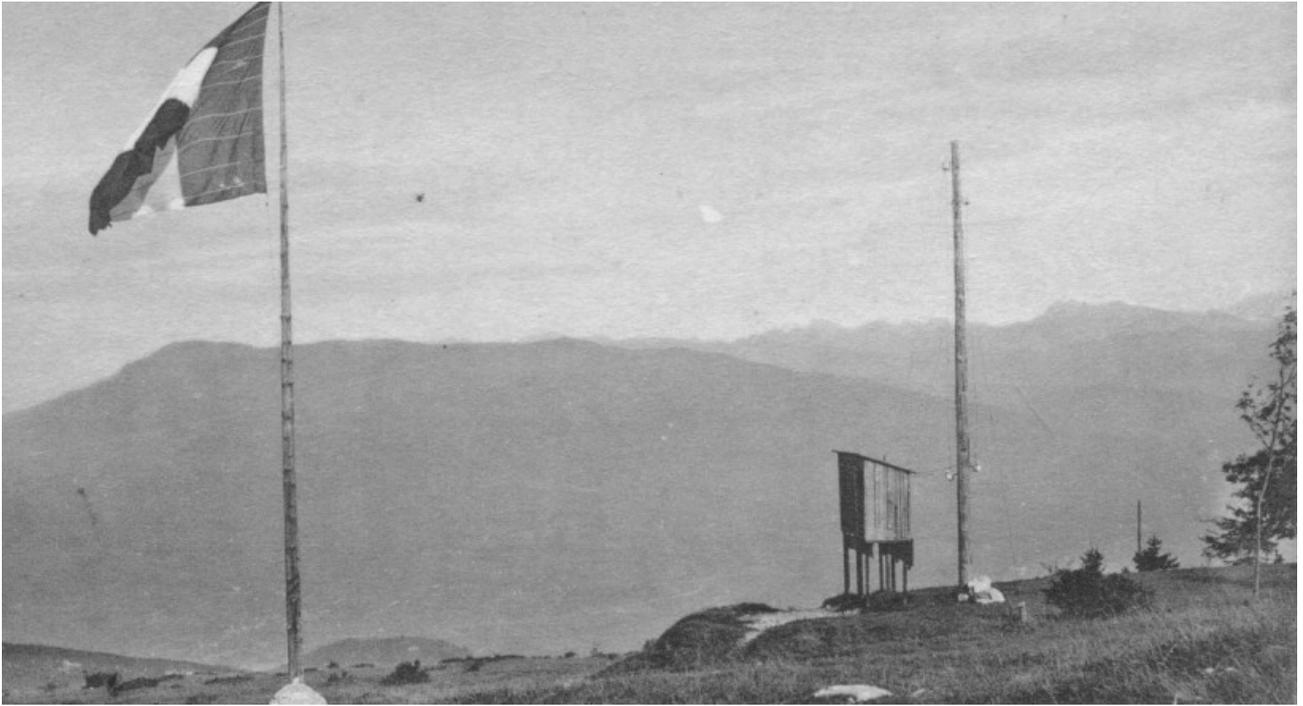
Illust. 32 – Le phare des Treize-Arbres établi en 1913 était visible de Genève et même du Jura ; ce phare comportait une caisse en bois fixée sur deux supports métalliques ; la dizaine de lampes de 120 volts était alimentée par le courant destiné à la traction des automotrices.
