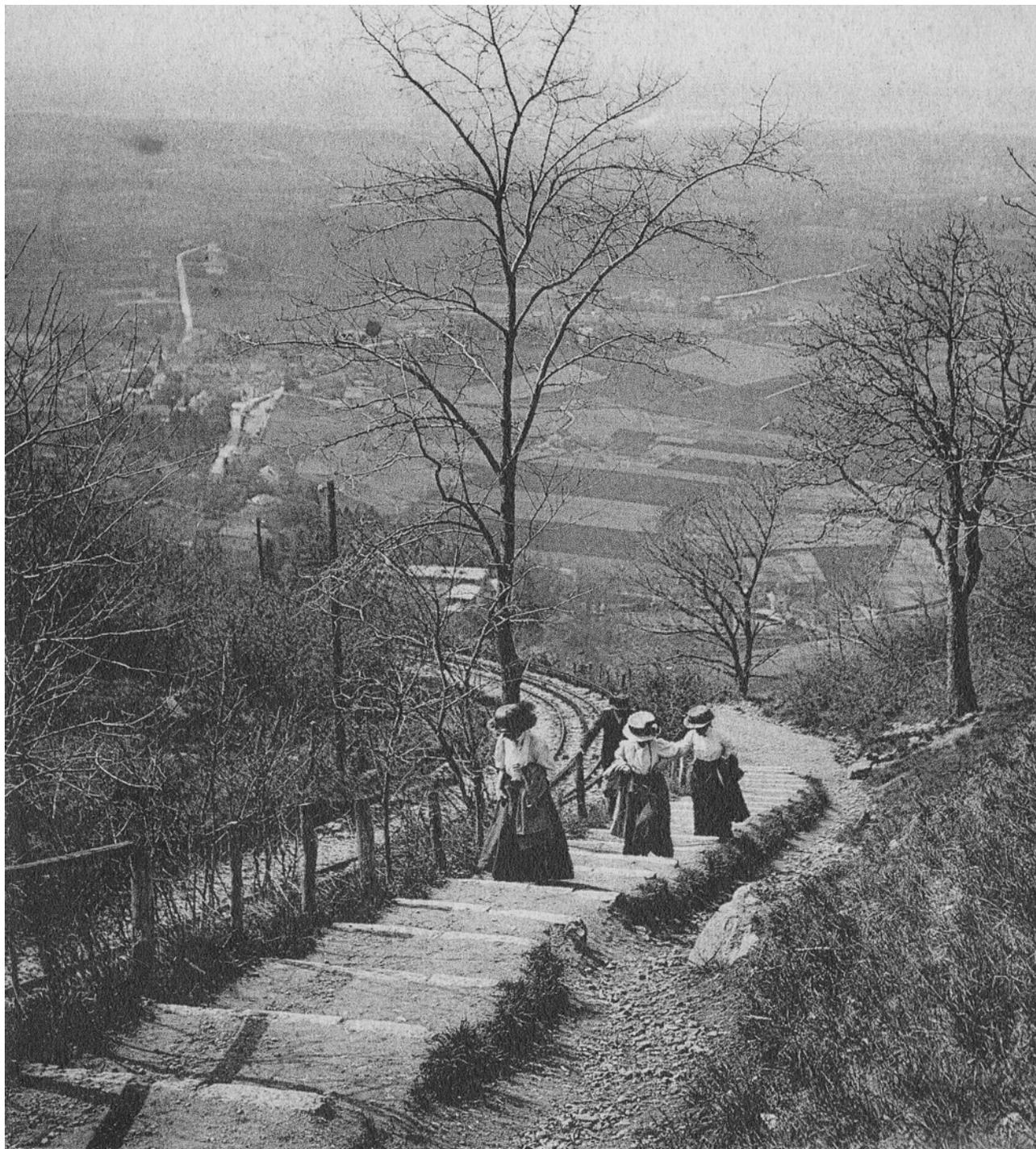
Illust. 07 – Nouvel escalier du Pas-de-l'Échelle réalisé lors de l'établissement de la ligne Veyrier – Monnetier en 1893 parallèlement à la voie ferrée en tranchée. Cet escalier de 120 marches remplace le sentier serpentant dans le vallon et complète l'ancien escalier aux 120 marches de pierre taillées dans le rocher pour passer le Pas-de-l'Échelle.
