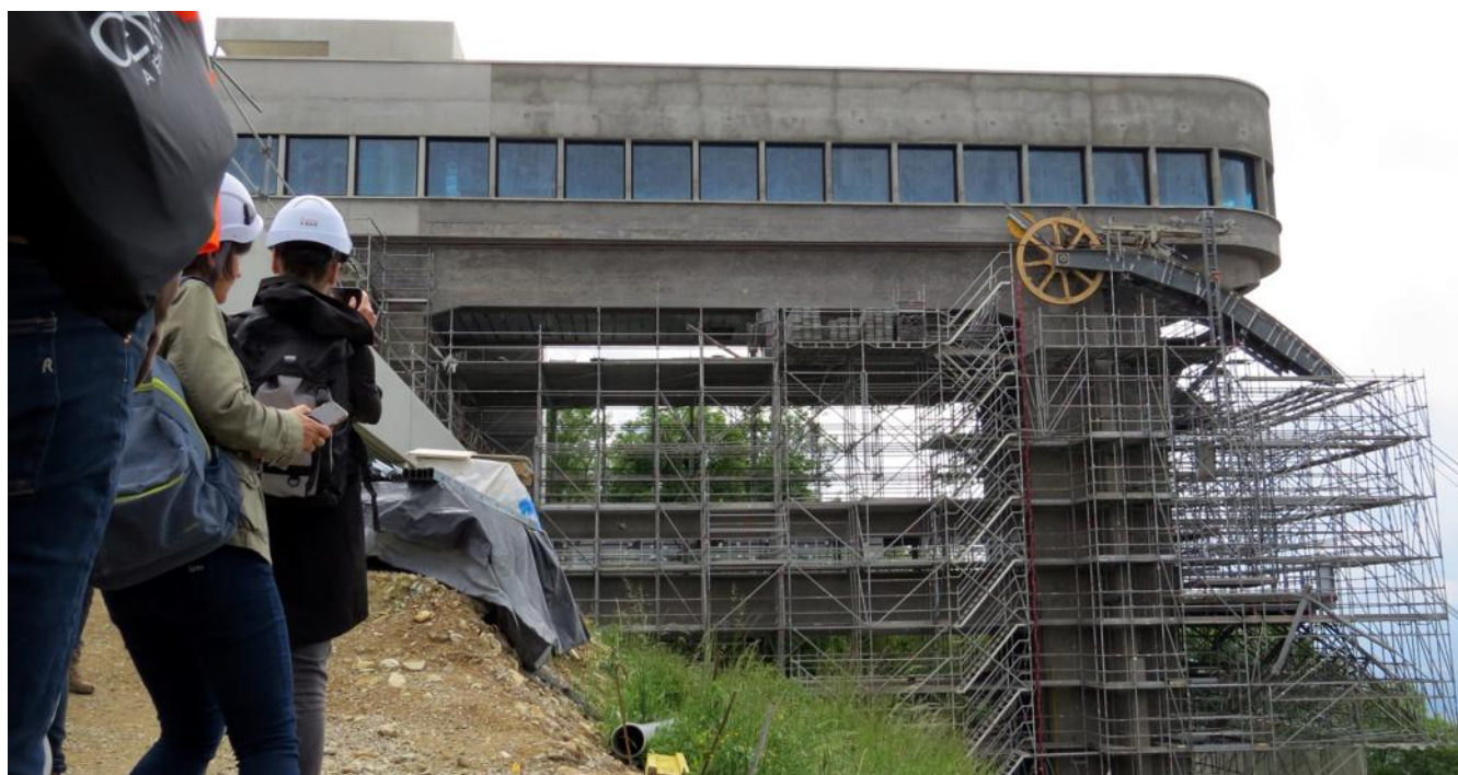
Le gros œuvre étant terminé, la gare d'arrivée progressivement débarrassée de ses échafaudages révèle une ligne élégante et élancée, sur fond de paysage lémanique. Photo Le DL/D.E.
