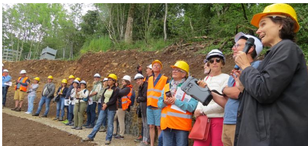
Claudia Devaux, l'une des architectes en charge du projet a détaillé devant un auditoire attentif, les particularités de ce chantier singulier. Photo Le DL/D.E.
